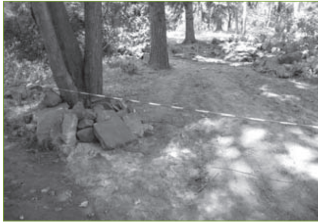
W TRAKCIE REALIZACJI
