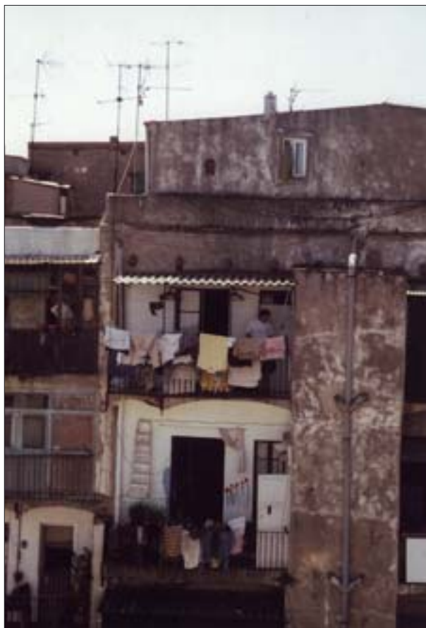
1. Kamienice w północnej części El Raval
