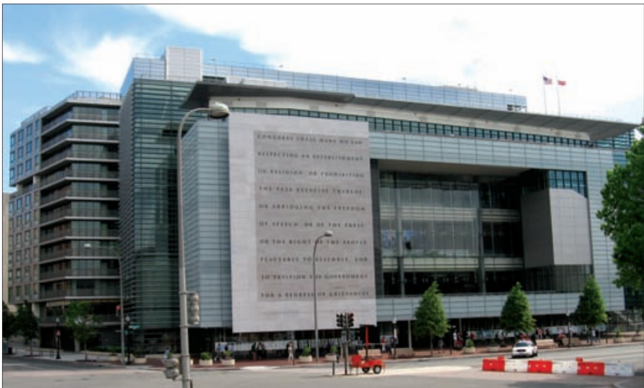
1. Newseum, widok od strony Pennsylvania Avenue, proj. Polschek Partnership Architects
