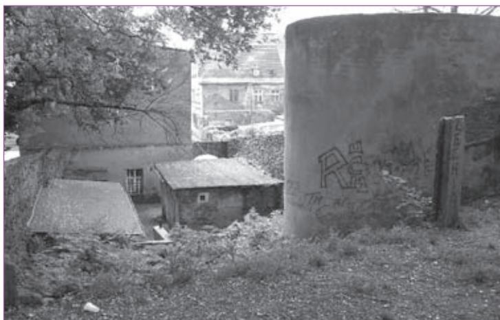
3. Dzierżoniów. Wtórnie zagospodarowane międzymurze.
