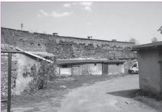
4. Świebodzice. Mury miejskie, odcinek północny o dobrze zachowanych cechach pierwotnej konstrukcji, obudowany.
