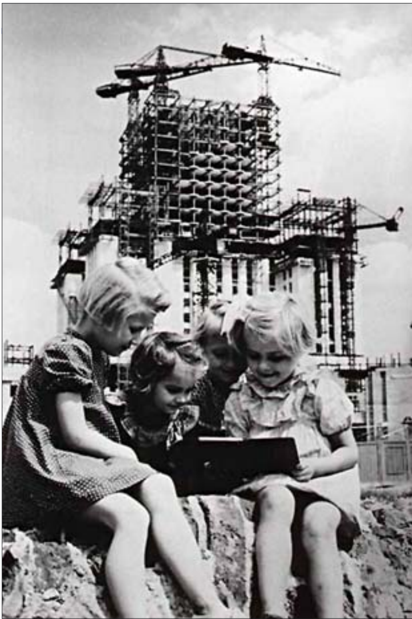
1. Budowa Pałacu Kultury i Nauki. Fot. Archiwum PKiN. 1. Construction of the Palace of Culture and Science. Photo: PKiN's Archive.
