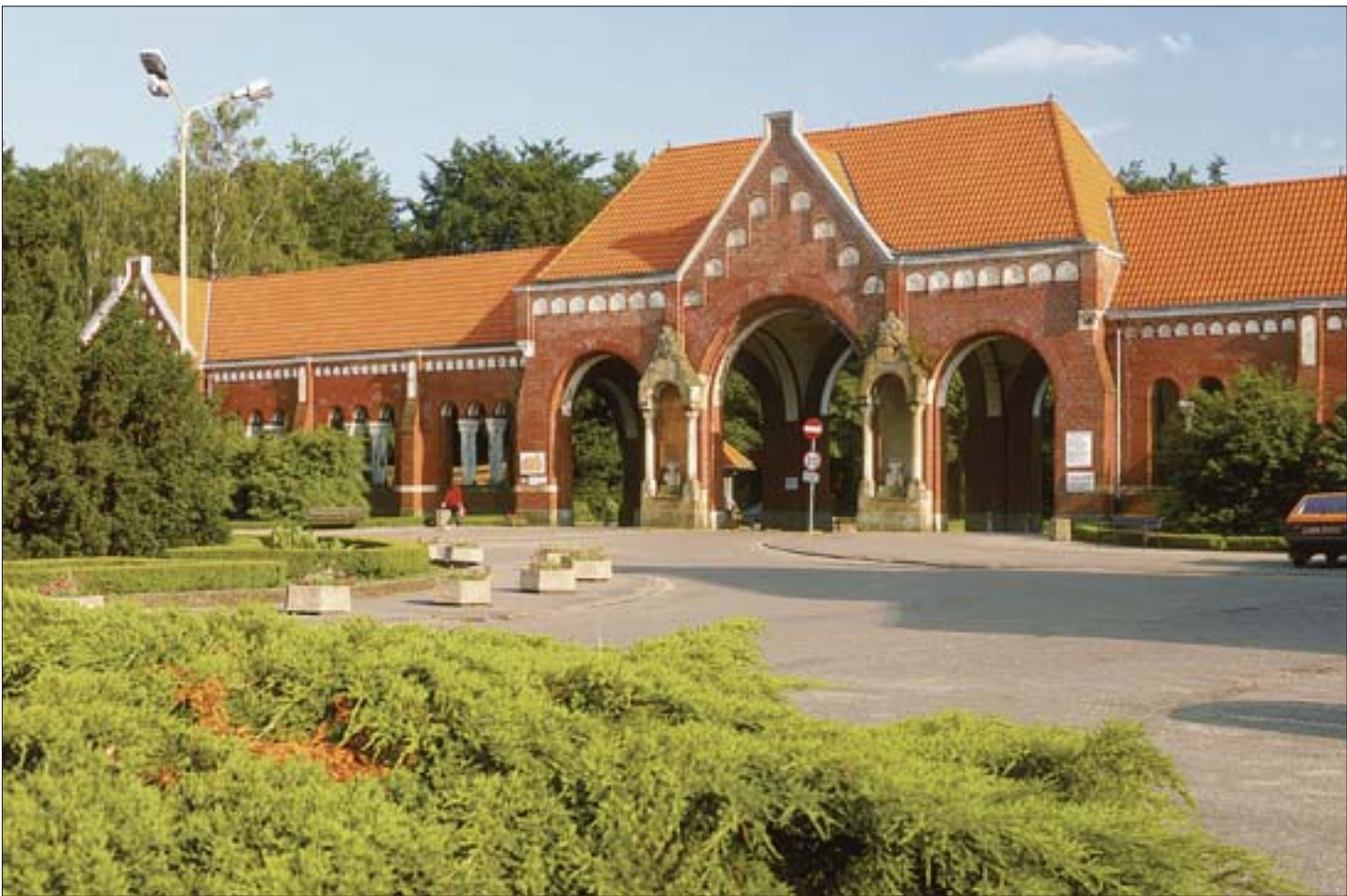
1. Brama główna, widok od strony zewnętrznej. Fot. G. Solecki. 1. Main gate, view from the outside. Photo: G. Solecki.
